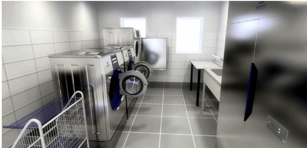
Översiktsbild över en av de mindre tvättstugorna på Centrumvägen 6 D.
